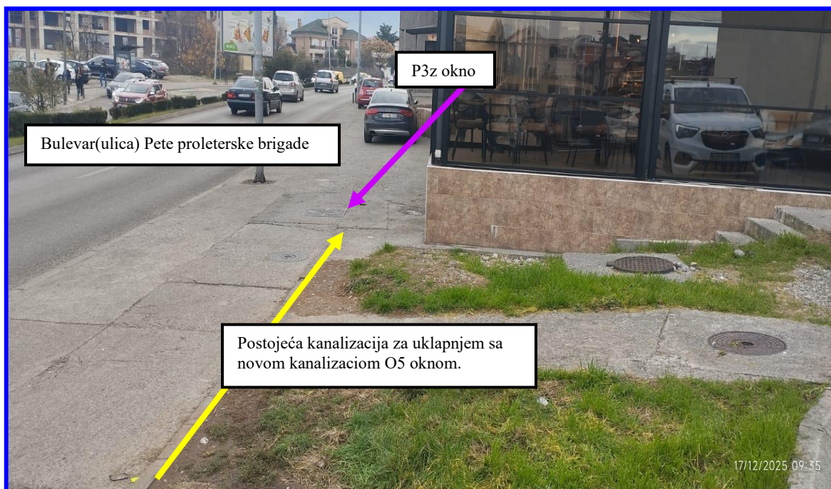
Slika 4: Orjentaciona pozicija postojeće kanalizacije na Bulevaru Pete proleterske brigade. Slikano sa desnog trottorara od grada prema kružnom toku kod Lukoil pumpe.
