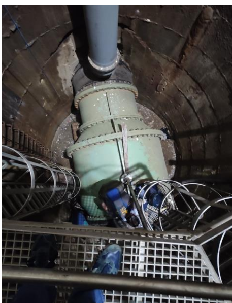
Slika 3: Prikaz igličastog zatvarača sa propratnim elementima
