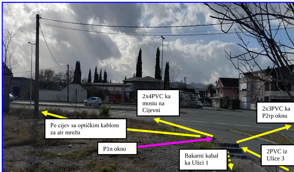
Slika 3: Iz P1n okna orjentacione trase kanalizacije i kabla u zemlji. Slikano od profila PR9 Ulice 1 prema raskrsnici sa magistralnim putem( u pravcu opadanja profila Ulice 1).
