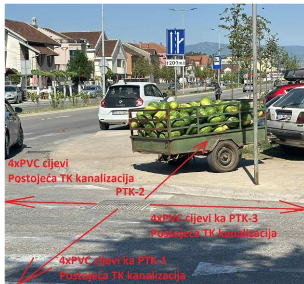
Slika 4: Postojeće okno PTK-2 sa pripadajućom instalacijom
