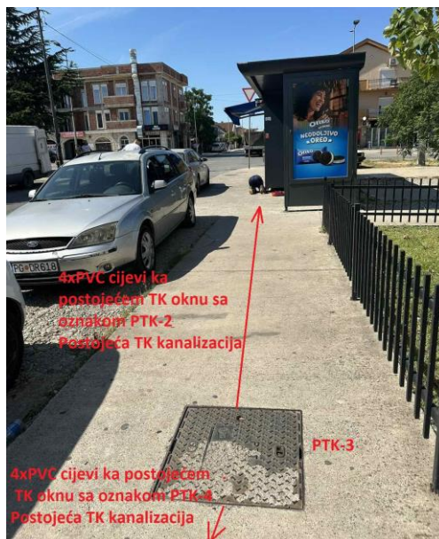
Slika 5: Postojeće okno PTK-3 sa pripadajućom instalacijom
