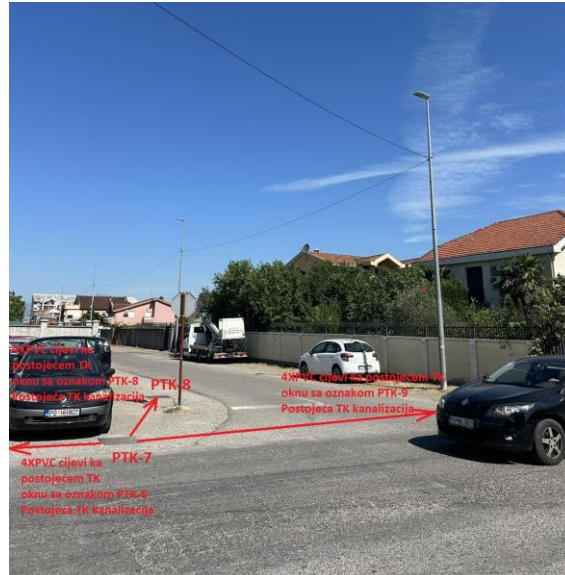
Slika 8: Postojeća okna PTK-7 i PTK-8 sa pripadajućom instalacijom
