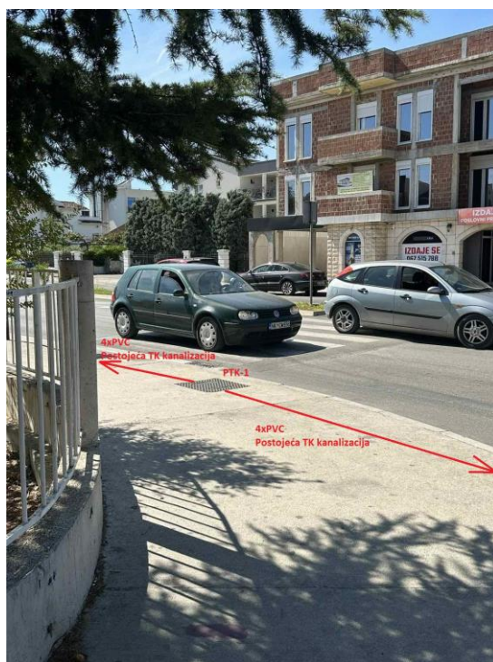
Slika 3: Postojeće okno PTK-1 sa pripadajućom instalacijom
