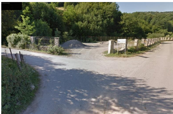
Slika br. 1. Prikaz priključka na predmetnu saobraćajnicu
