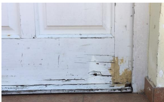
F24 – F30 Vrata - Pozicija VIII - IX - X Oštećenja na poziciji vrata na prizemlju objekta ↑
