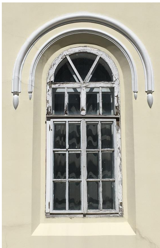
F3 – F4 Spoljni i unutarnji izgled fasadnog dvostrukog dvokrilnog prozora – Pozicija I ↑
