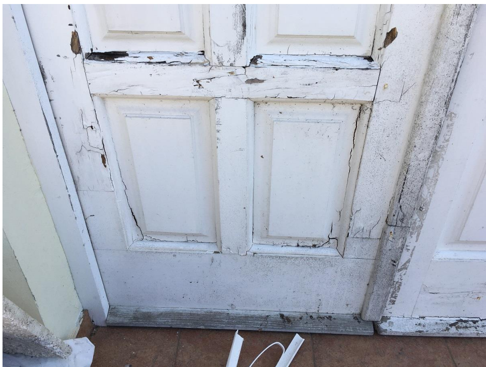
F31 – F32 Vrata - Pozicija VIII - IX - X Oštećenja na poziciji vrata na prizemlju objekta ↑ ↓
