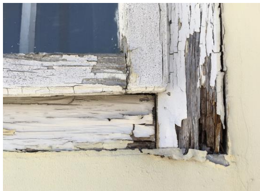
F5 – F6 Proces truljenja na spoljnim - fasadnim dvokrilnim prozorima – Pozicija I ↑
