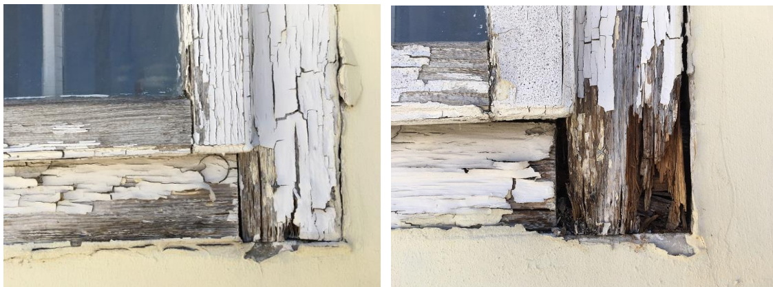
F7 – F8 Proces truljenja na spoljnim - fasadnim dvokrilnim prozorima – Pozicija I ↑
