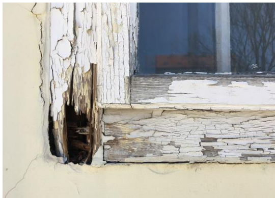
F5 – F6 Proces truljenja na spoljnim - fasadnim dvokrilnim prozorima – Pozicija I ↑
