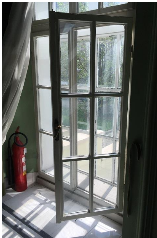
F3 – F4 Spoljni i unutarnji izgled fasadnog dvostrukog dvokrilnog prozora – Pozicija I ↑
