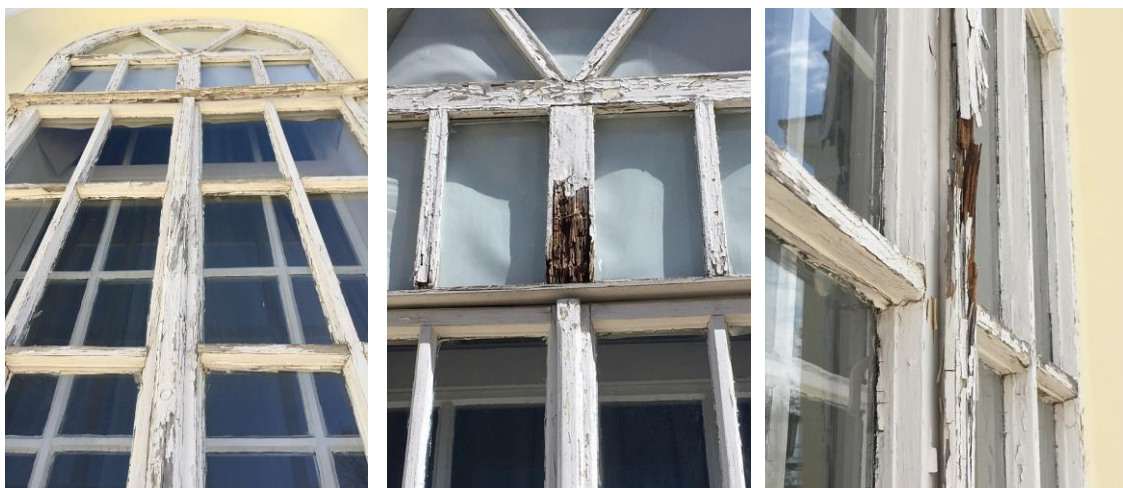
F9 – F11 Proces truljenja na spoljnim – fasadnim otvorima pozicije I ↑
