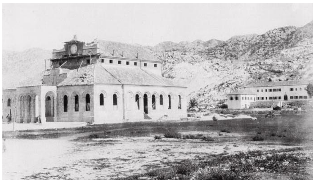
F3 – Završni grubi građevinski radovi. Fotografija urađena okvirno krajem 1888 godine ↑
