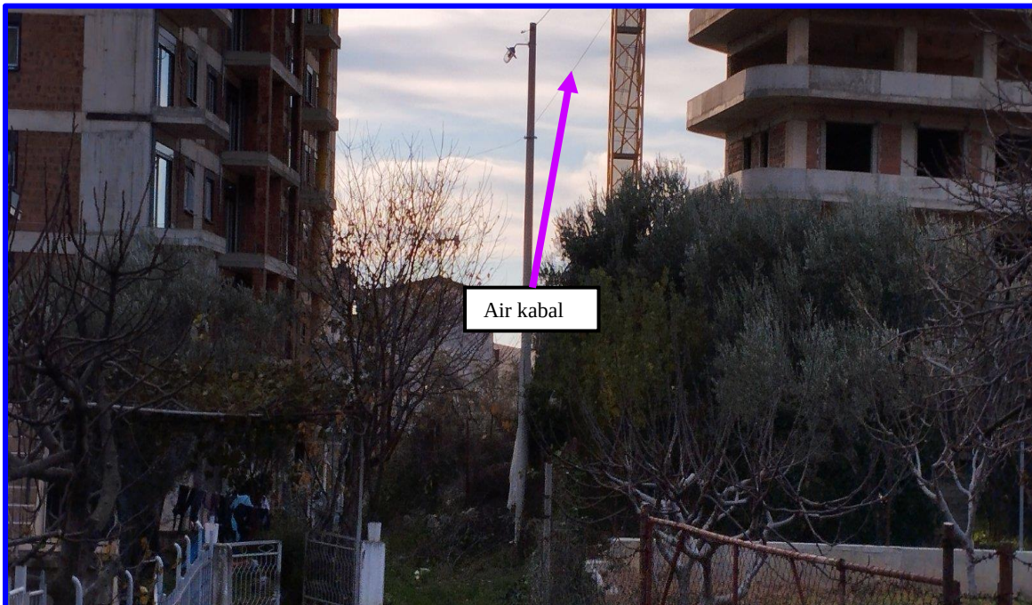
Slika 3: Betonski stub sa air kablom iza profila PR13. Slikano od profila PR16 u pravcu opadanja profila.
