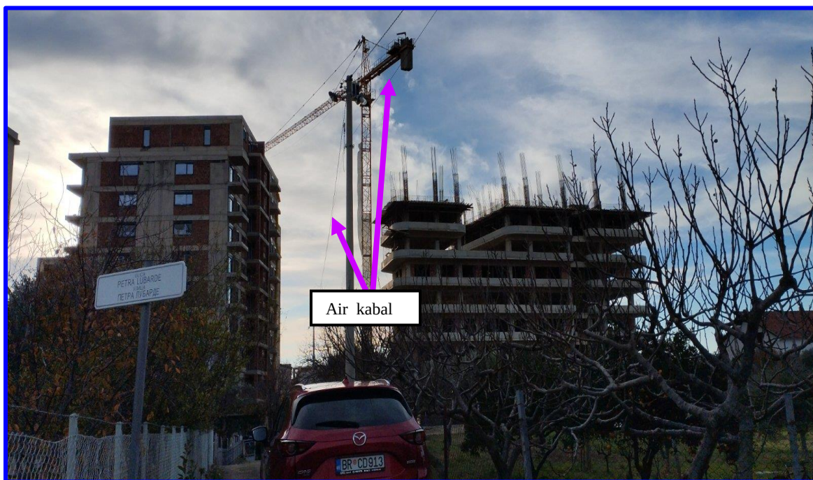
Slika 4: Betonski stub sa air kablom iza profila PR19. Slikano od profila PR20 u pravcu opadanja profila.
