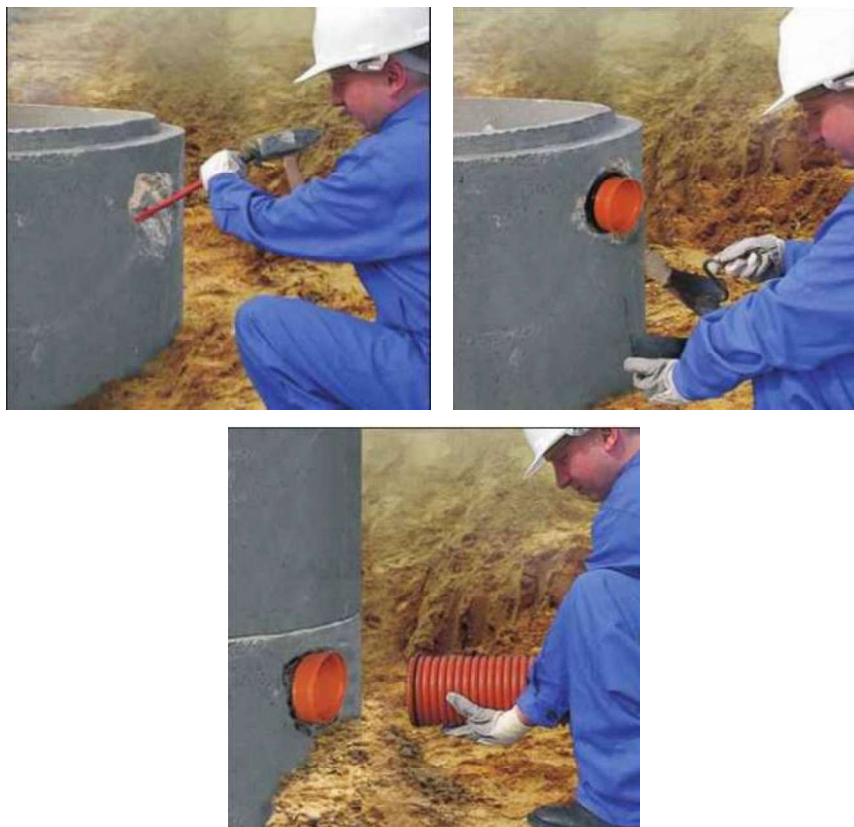
Slika 29: Spajanje PP cijevi na betonski šaht
