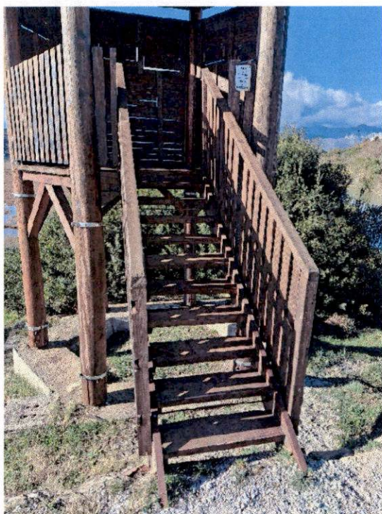
Slika br.7: Stepenište osmatračnice sa ogradom
