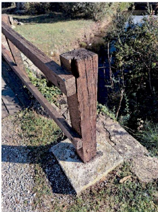
Slika br.3: Ograda mosta
