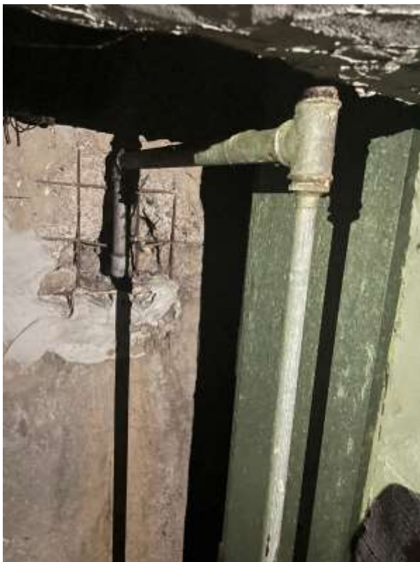
(odvod za navodnjavanje)
