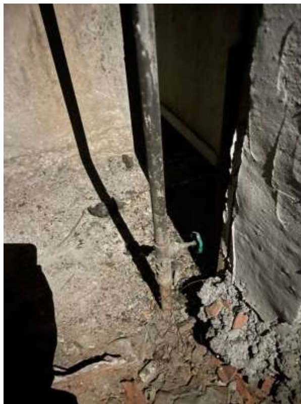
(postojeća cijev u podu koja se demontira)
