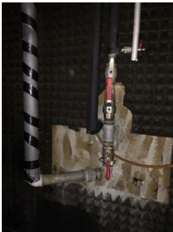
(postojeći dovod vode u objekat)
