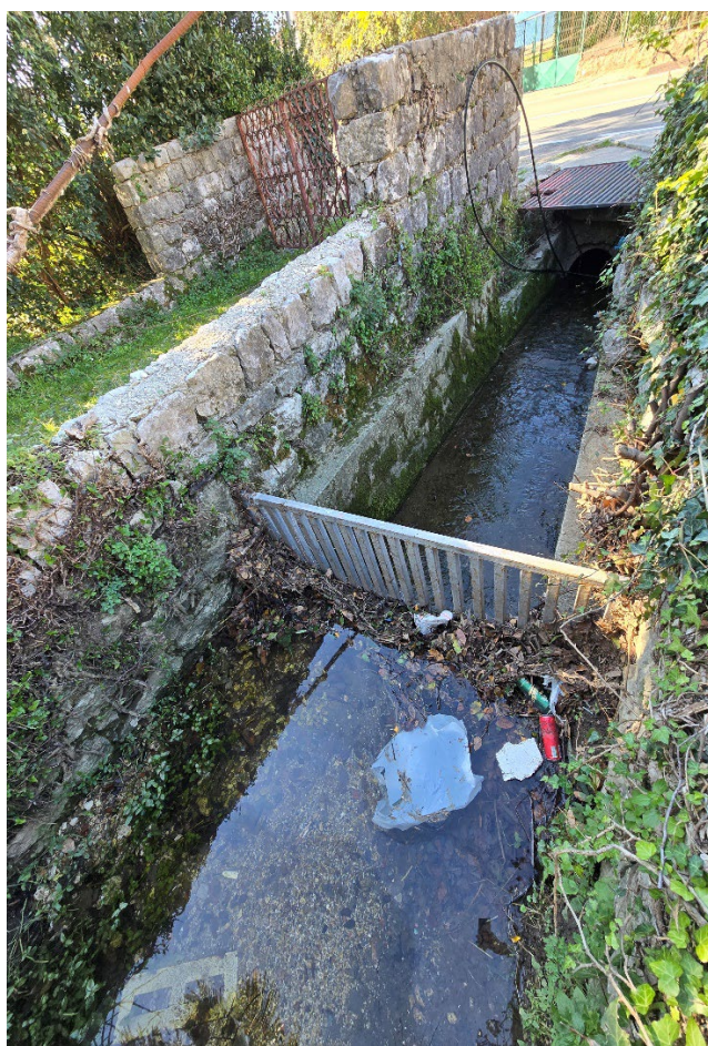
Fotografije kanala iznad propusta sa rešetkom
