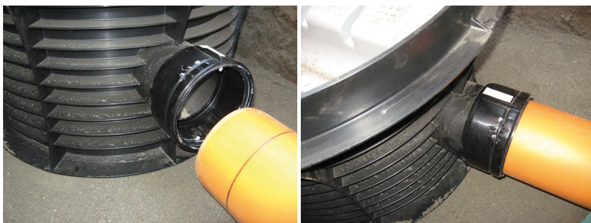
Slika 5 i 6: Izvođenje spoja šahta sa PVC cijevima
