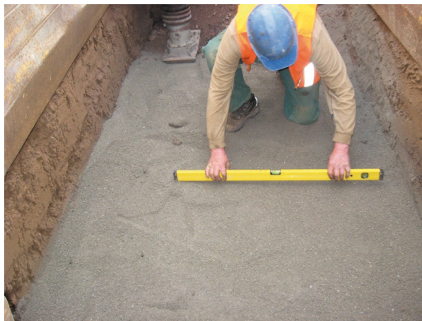
Slika 1 i 2: Priprema podloge za polaganje šahtova
