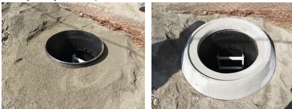
Slika 9 i 10: Postavljanje betonskog prstena za prihvatanje opterećenja
