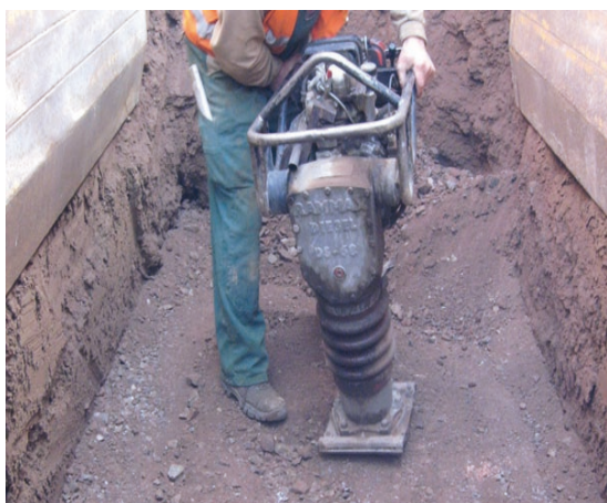
Slika 1 i 2: Priprema podloge za polaganje šahtova
