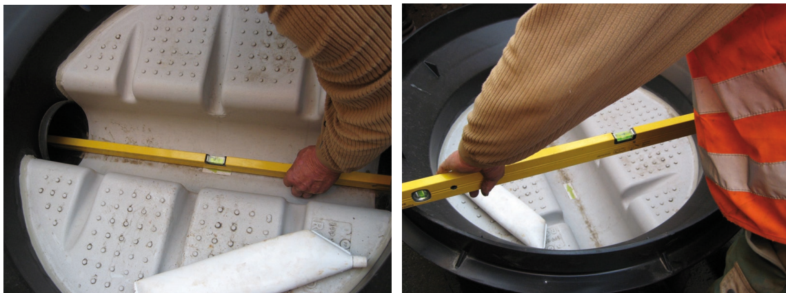
Slika 3 i 4: Kontrola položaja odvoda
