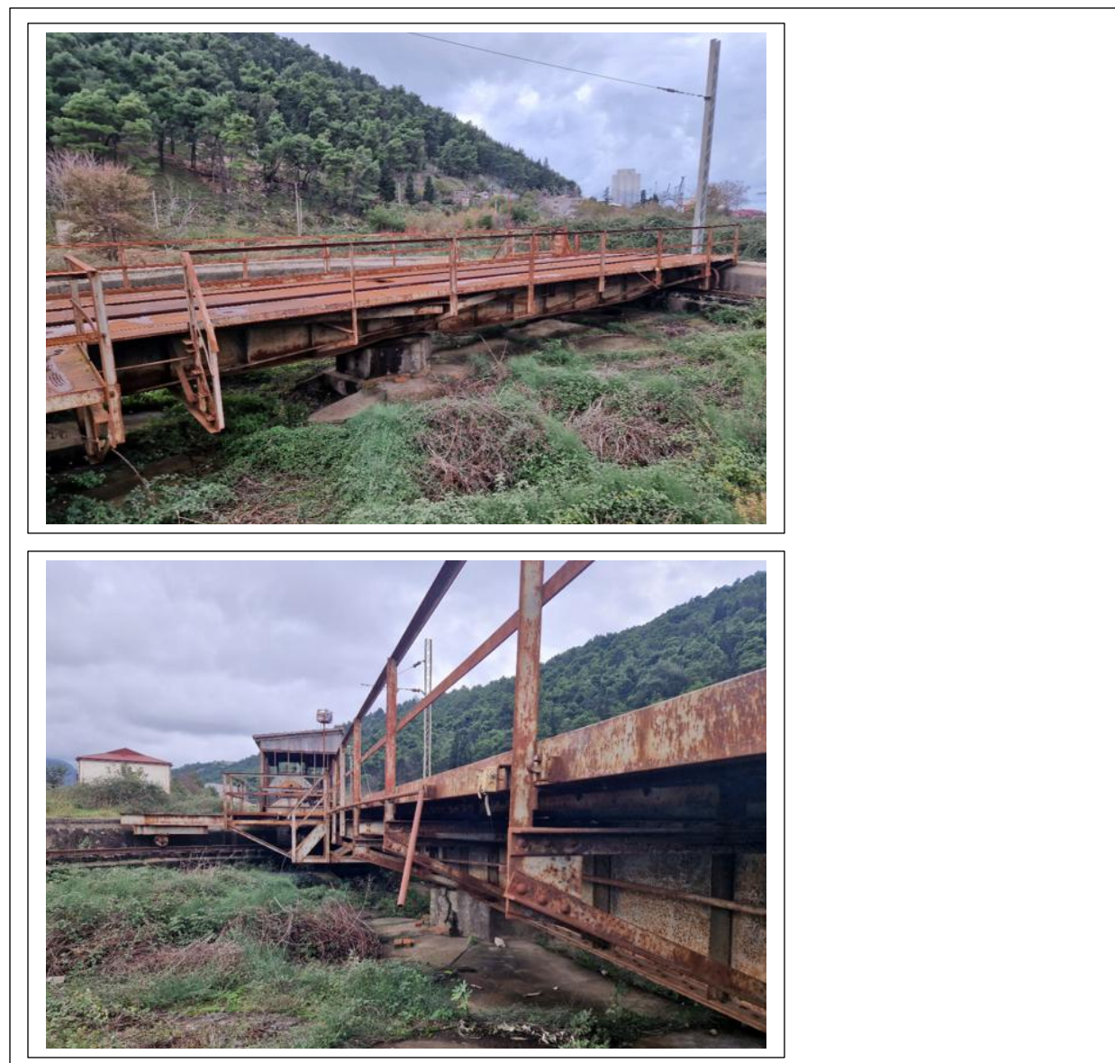
Slika 1-Osnovni izgled trenutnog stanja konstrukcije okretnice
