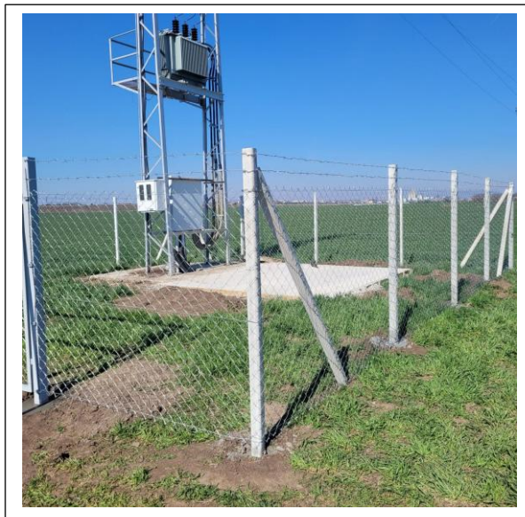
Slika P2-3-Ograda sa betonskim stubovima i dodatkom dva reda bodljikave žice
