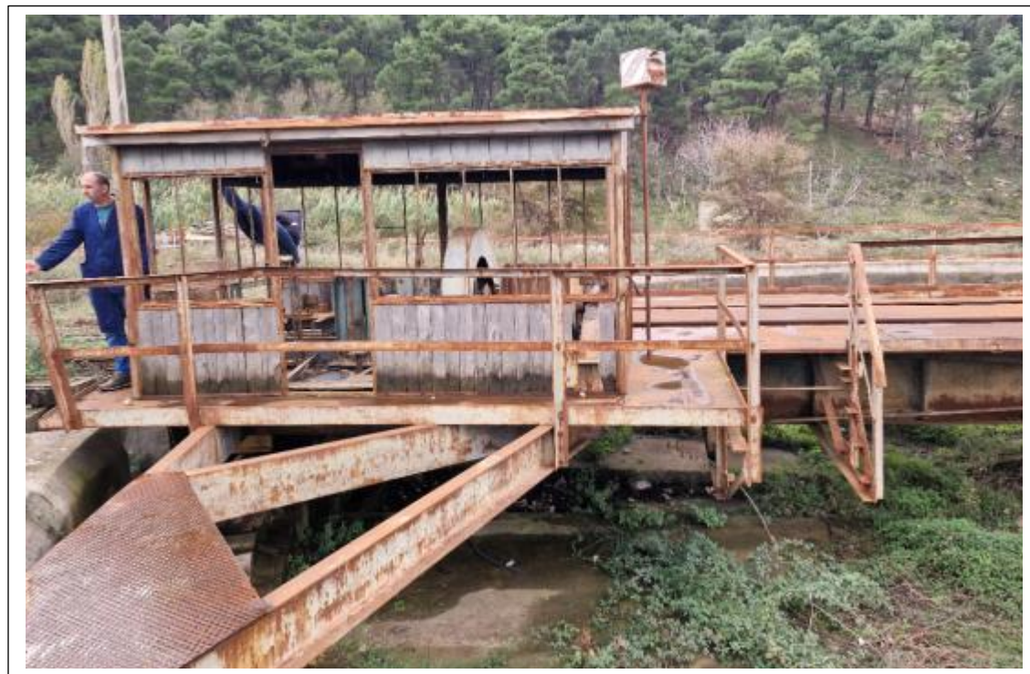
Slika 3a-Sadašnji izgled kućice sa osnovnim pogonom i mosta koji nosi pomoćni točak
