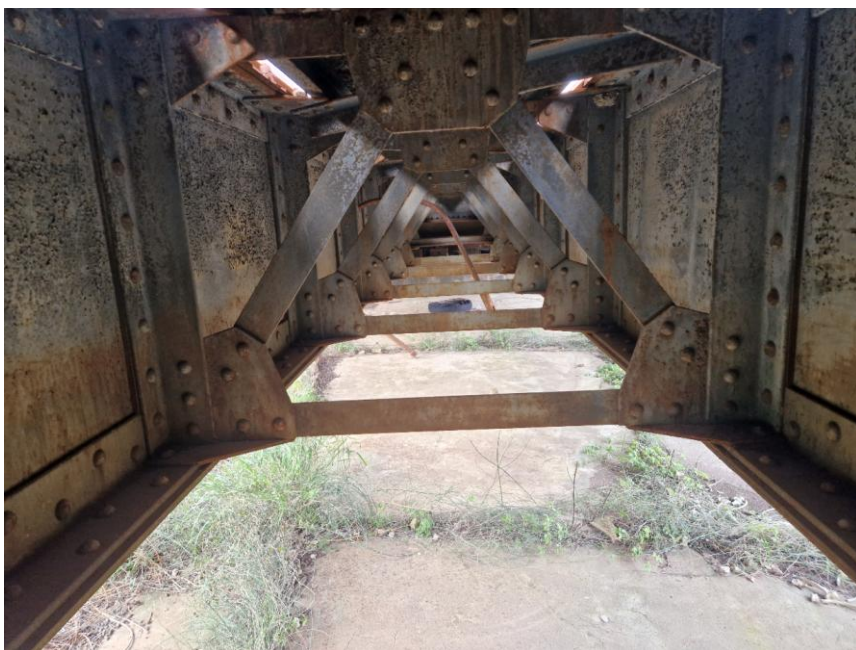
Slika 3f-Veza između dve grede-rešetka sa zakovicama
