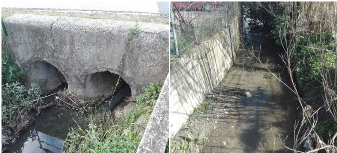
Slike 2 i 3: Suženje postojećeg profila korita kanala na zacjevljenju sa 2xØ1000mm ispod ukrštanja sa lokalnim putem
