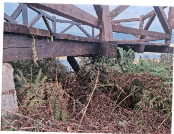
Slika 3 – Drvena konstrukcija na koju je oslonjena platforma
