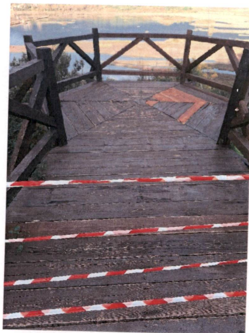
Slika 2 – Postojeća zaštitna ograda i platforma
