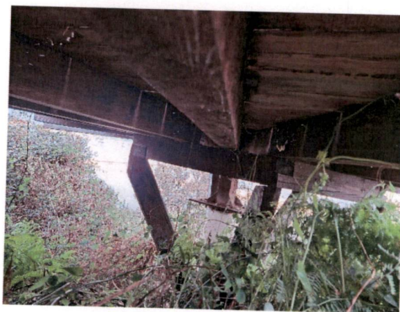
Slika 4 – Drvena konstrukcija na koju je oslonjena platforma
