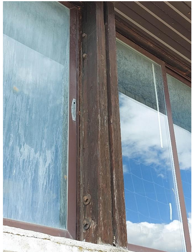
Slika 16. Oštećenja fasadnih stubova u maloj sali – unutrašnjost i spoljašnost objekta
