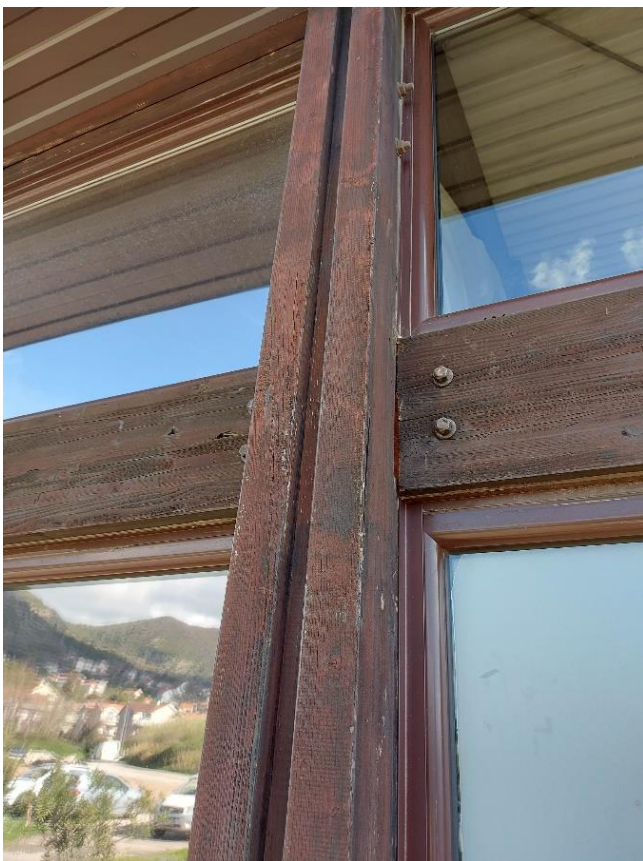
Slika 25-1. Oštećenja drveta fasadnih greda ulaznog hola
