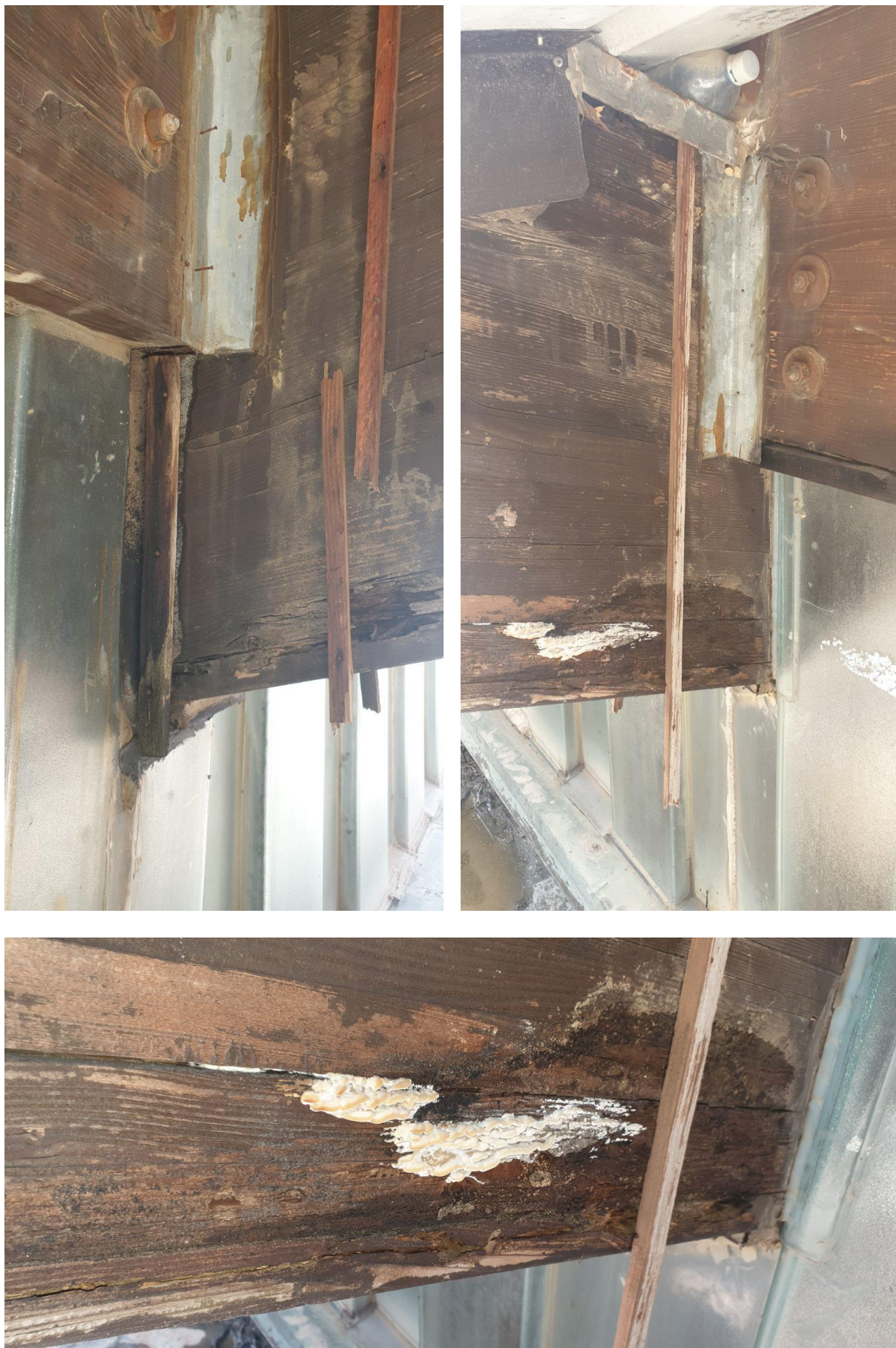
Slika 21-2. Oštećenja drveta vanjskog dijela glavnog nosača male sale (u otvorenoj krovnoj niši) na mjestu njegovog prodora kroz staklenu zidnu stijenu male sale
