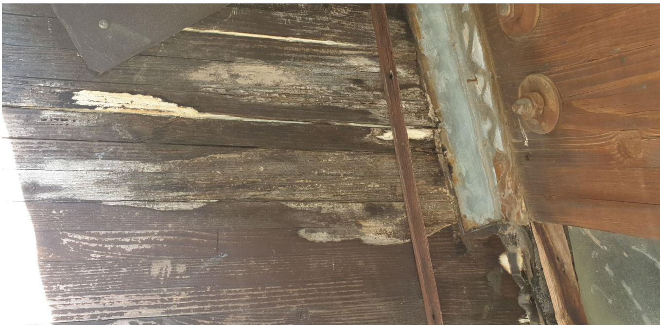
Slika 20. Promjene boje, kao prvi znaci početne faze truljenja drveta a/ zidne podvlake velike sale, b/ glavnog nosača male sale
