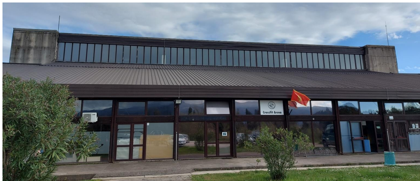
Slika 22. Fasadni (ulazni) zid ulaznog hola
