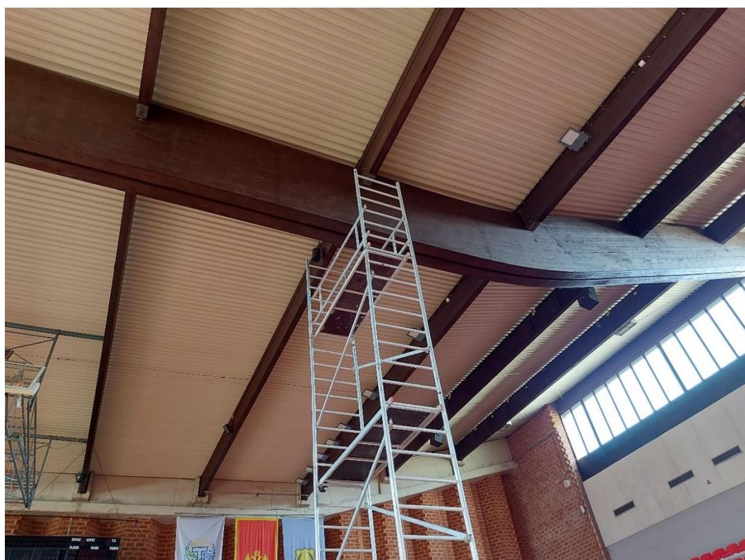
Slika 6. Inicijalni položaji skele sa koje je vršen pregled konstrukcije
