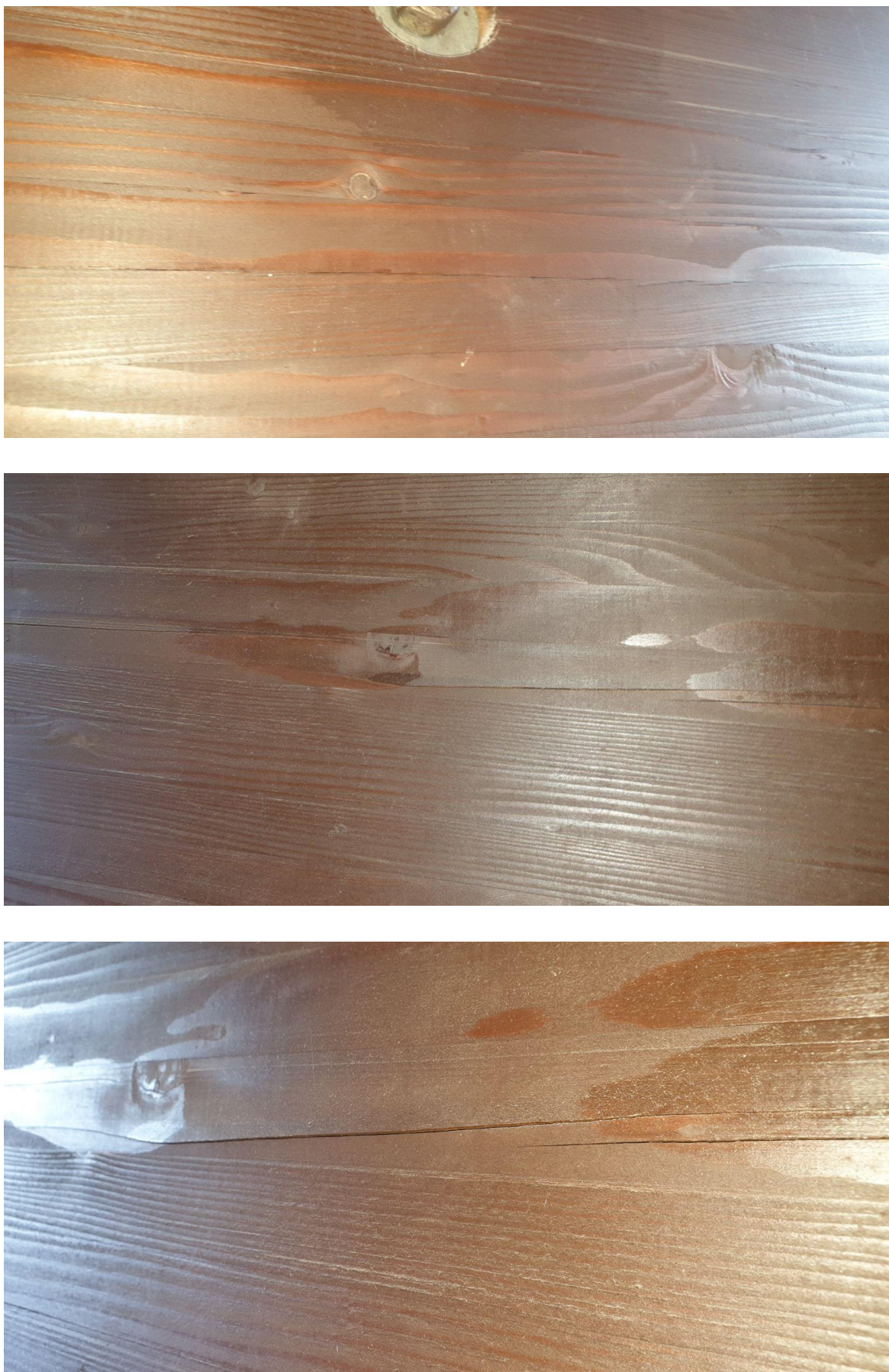
Slika 11. Prsline u glavnom nosaču, sa bočne strane, dubine do 10 mm
