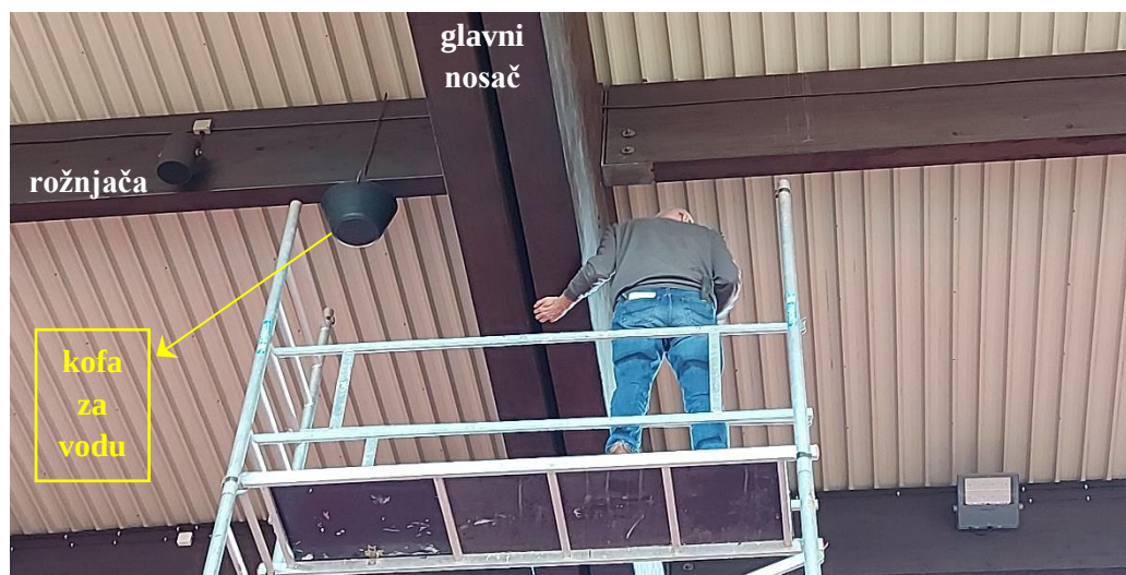
Slika 8. Detalj pregleda konstrukcije
