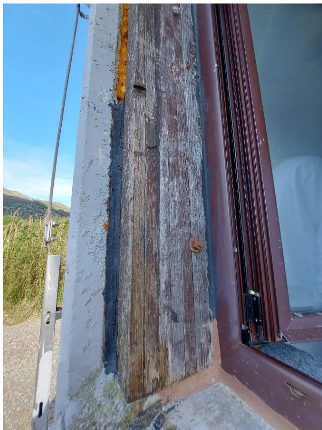
Slika 24-2. Oštećenja drveta fasadnih stubova ulaznog hola
