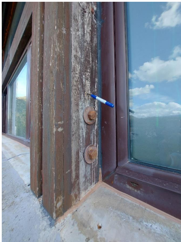
Slika 23. Proba šilom – fasadni stub u ulaznom holu
