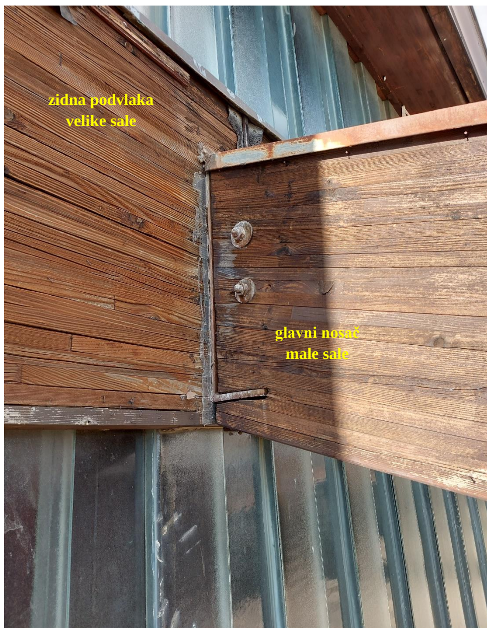
Slika 17. Veza glavnog nosača male sale i zidne podvlake velike sale (spoljašnost objekta – otvorena krovna niša)
