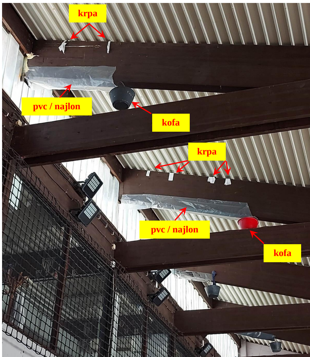
Slika 14. Prokišnjavanje i skupljanje kišnice u maloj sali
