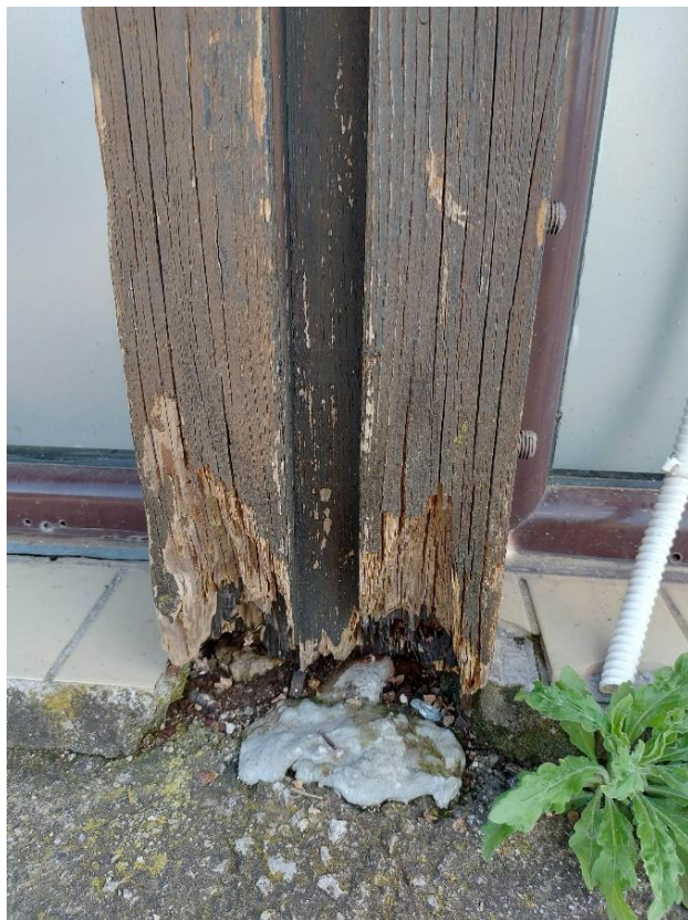
Slika 24-1. Oštećenja drveta fasadnih stubova ulaznog hola
