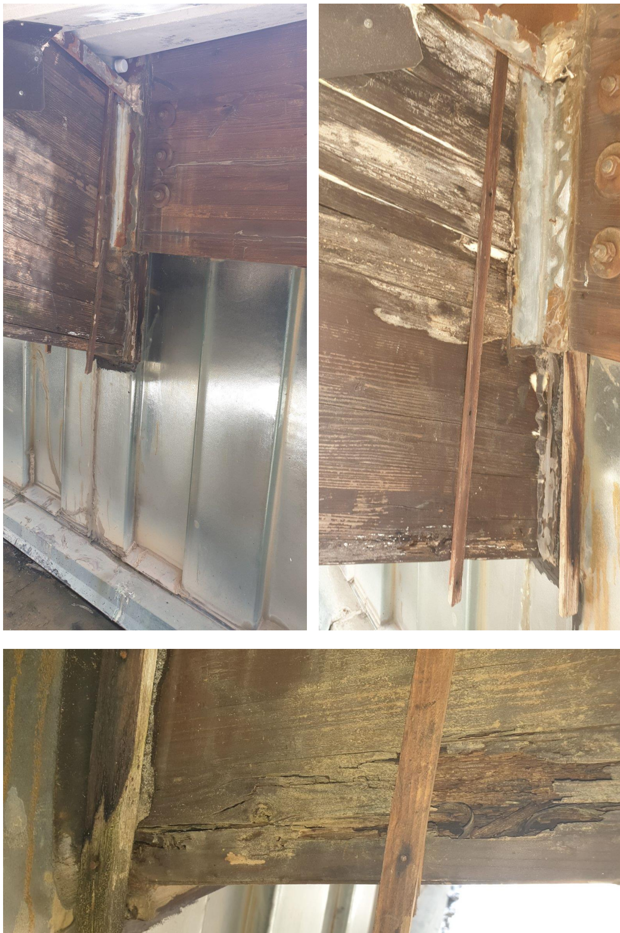
Slika 21-1. Oštećenja drveta vanjskog dijela glavnog nosača male sale (u otvorenoj krovnoj niši) na mjestu njegovog prodora kroz staklenu zidnu stijenu male sale
