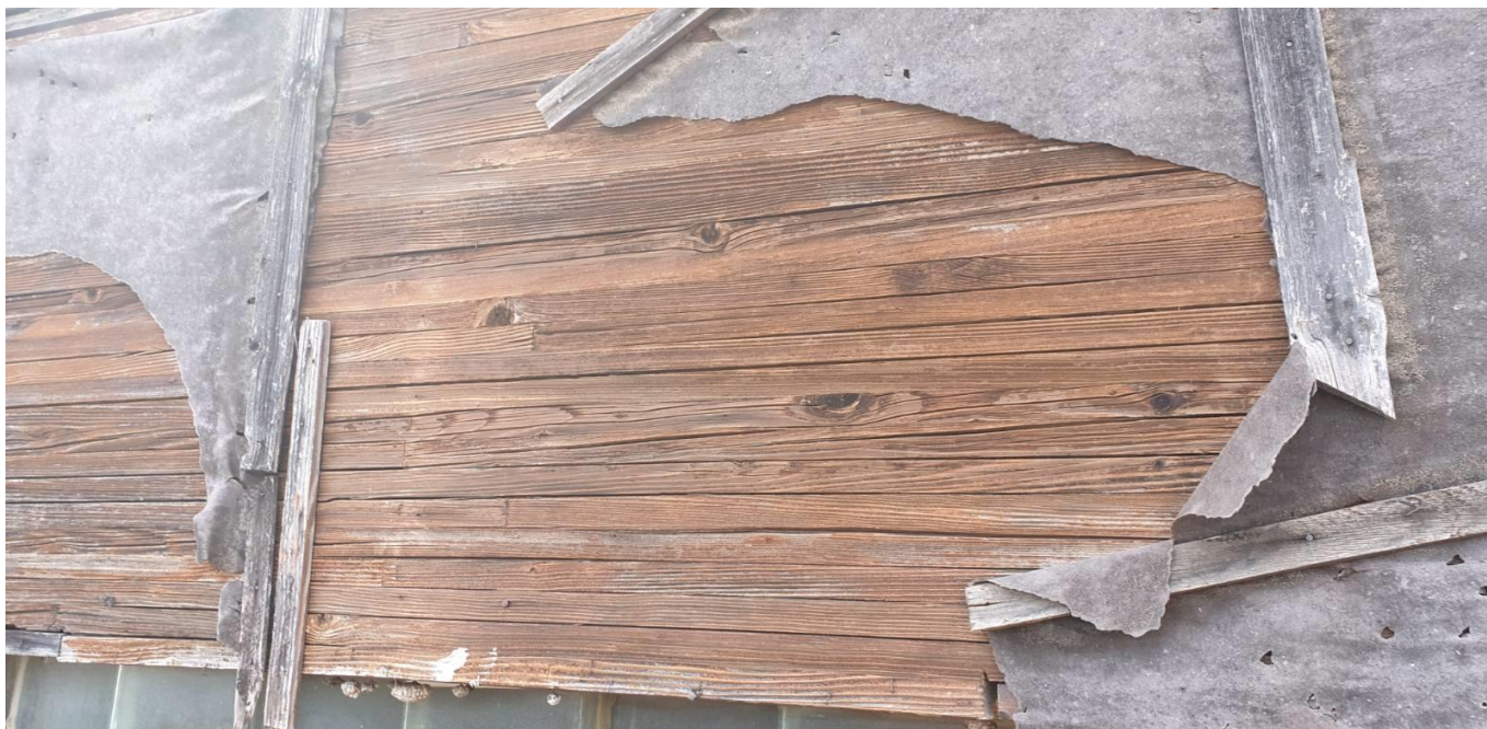
Slika 19. Neadekvatna zaštita zidne podvlake velike sale ter-hartijom
