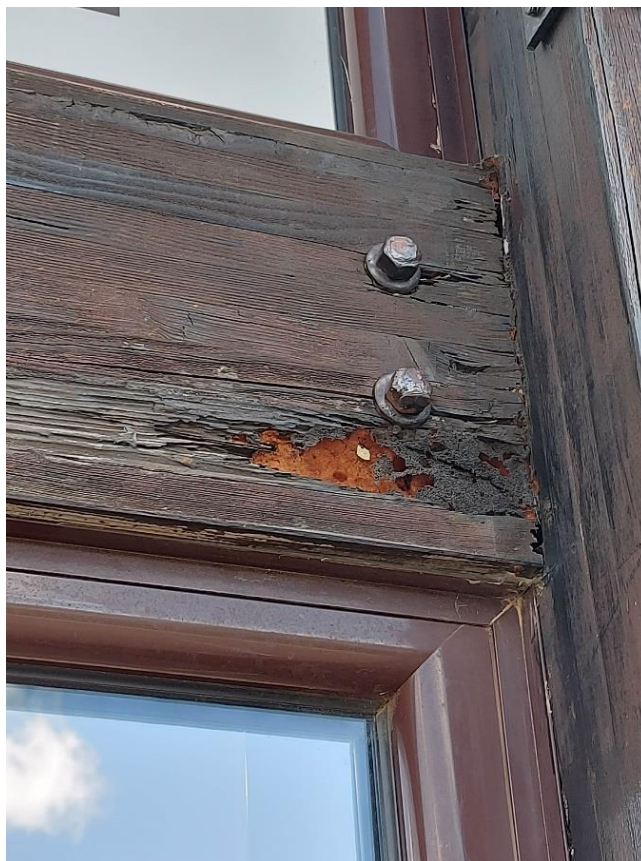
Slika 25-1. Oštećenja drveta fasadnih greda ulaznog hola
