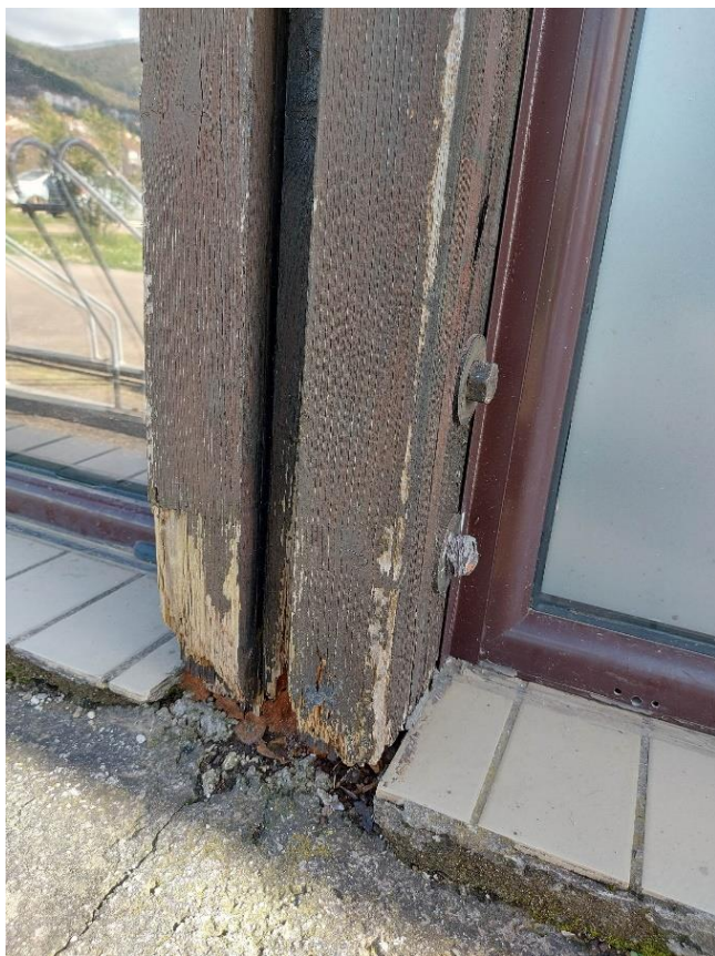
Slika 24-2. Oštećenja drveta fasadnih stubova ulaznog hola
