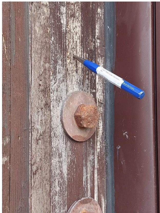
Slika 23. Proba šilom – fasadni stub u ulaznom holu
