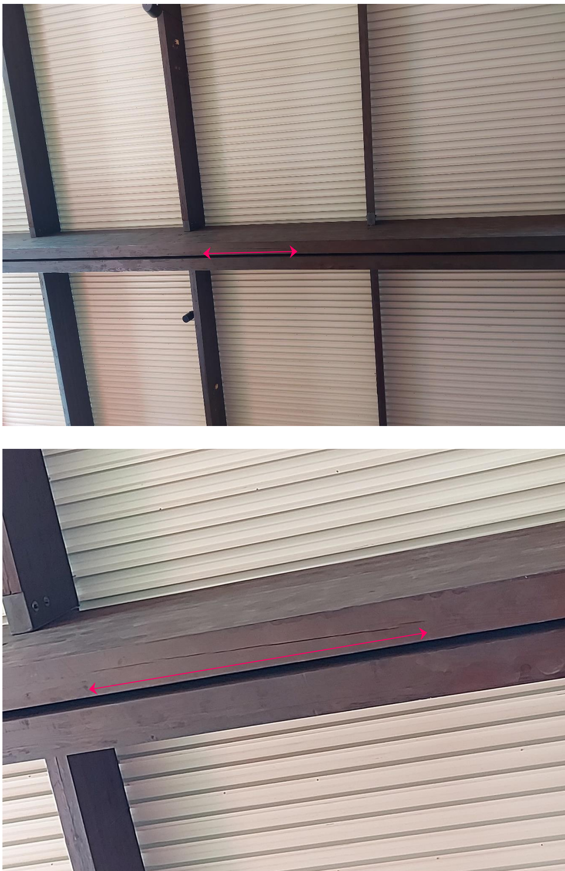
Slika 10. Prslina u glavnom nosaču, sa donje strane, dubine do 30 mm
