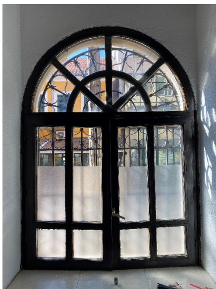
Prilog 8. Karakteristični prozor na uličnoj fasadi
