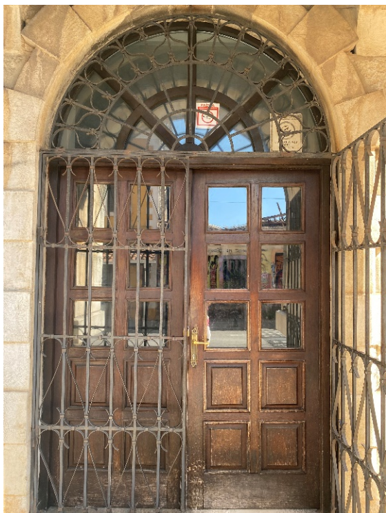
Prilog 10. Glavni- primarni ulaz
