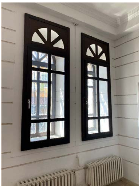
Prilog 14. Unutrašnji drveni prozori
