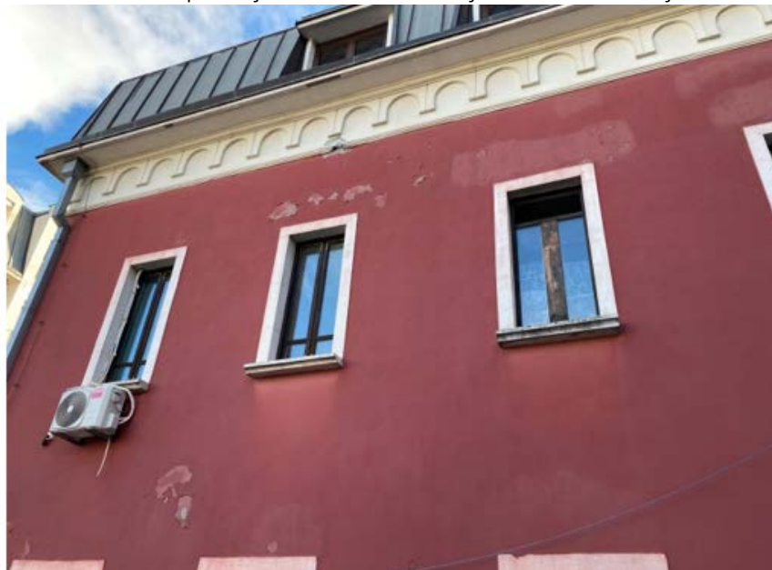
Prilog 6. Prozori na spratu i krovni vijenac
