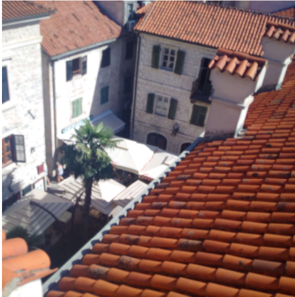
Dio krova koji se sanira
