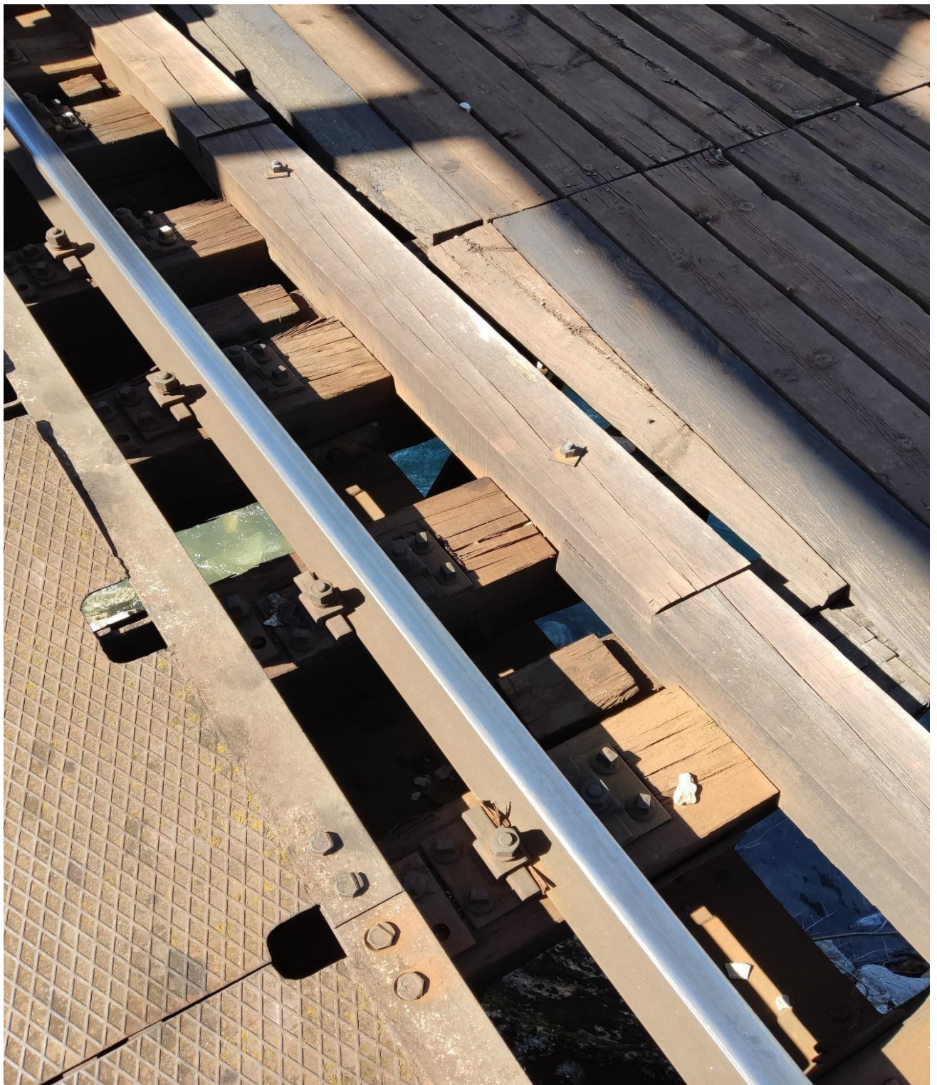
Poklopne grede na mostu
